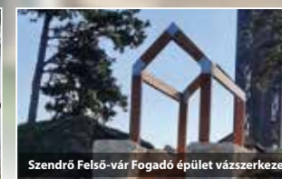
Szendrőlő Felső-vár Fogadó épület vázszerkezet
