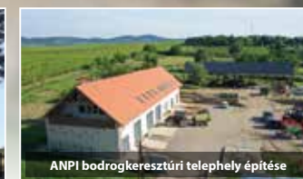
ANPI bodrogkeresztúri telephely építése
