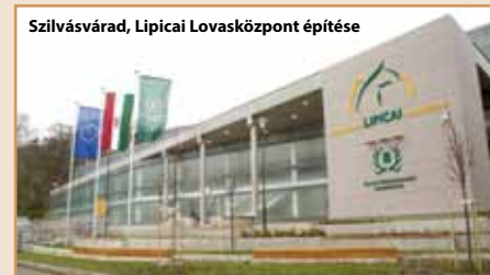
Szilvásvárad, Lipicai Lovasközpont építése
